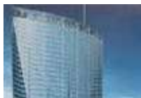
中國北京天山世紀廣場 Tianshan Century Plaza, Beijing
